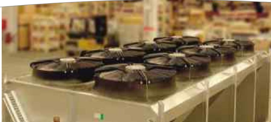
嚴密控制風機，可以節能，最低限度地控制噪音和氣流。
